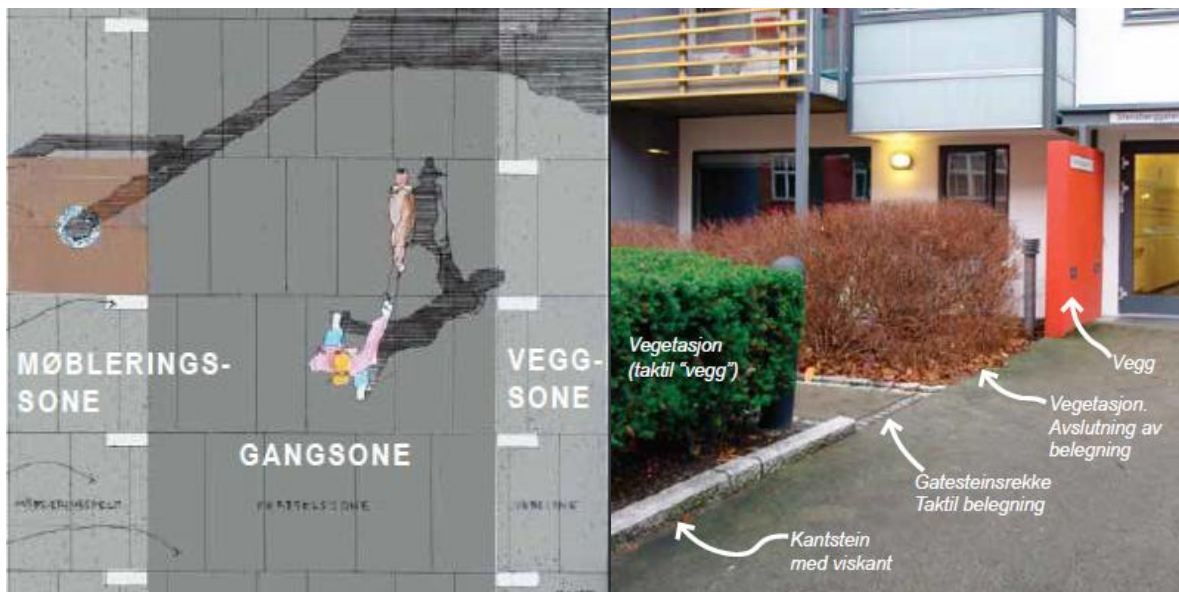
Figur 23: Tydelig soneinndeling av vei kan skjer med taktil og/eller visuell forskjell i belegg, men også med vegetasjon og kantsteiner (bildene fra https://www.vegvesen.no .)
