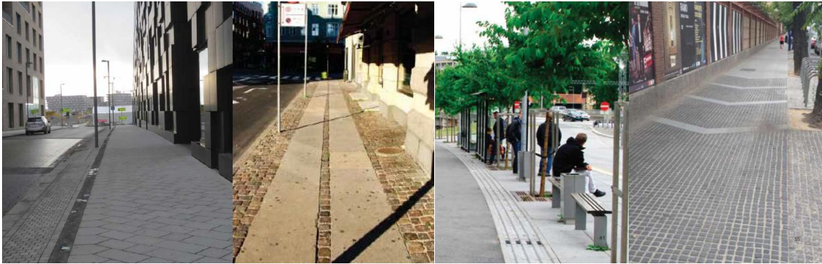
Figur 22: Tydelig forskjell mellom beleggstein som gir god kontrast enten taktil og/eller visuell og deler veien i forskjellige soner kan fungerer som naturlig ledelinje.
