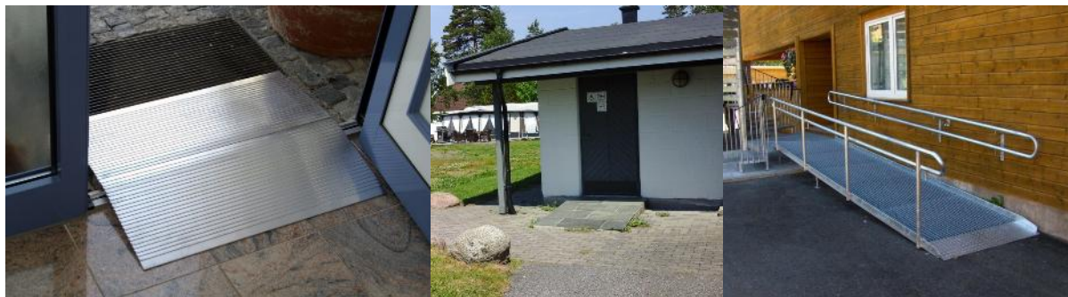
Figur 11: Terskelbro til venstre, skråningen (kartlegges som rampe) i midten og rampe på høyre.
